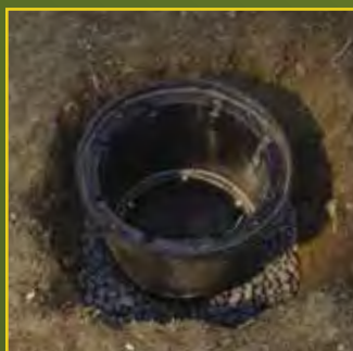
Pre-install pour box.
